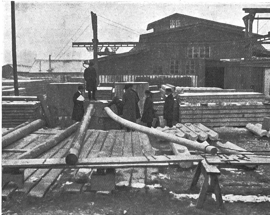
Fig. 10. Anordnung der Belastungsversuche mit „Universalsockeln“.
