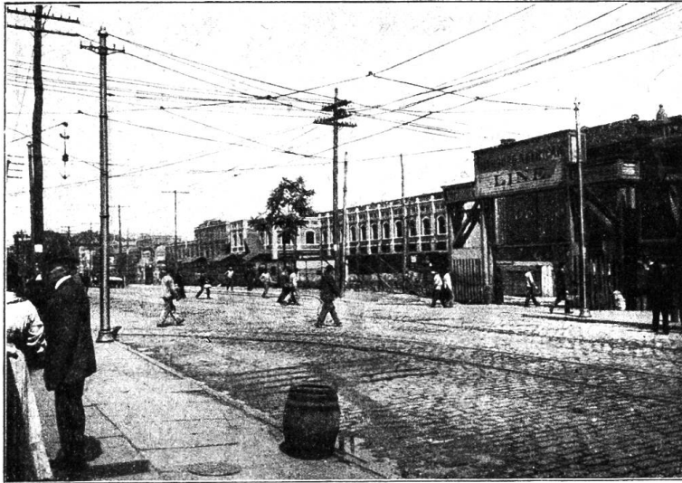
Fig. 1 zu Fussnote Seite 279. Hoch- und Niederspannungs- und Schwachstrom-Freileitungen für Licht und Telephon in Hoboken N.-Y.
