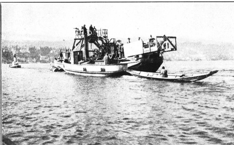
Fig. 8. Beim Kabelverlegen in der Mitte des Sees.
