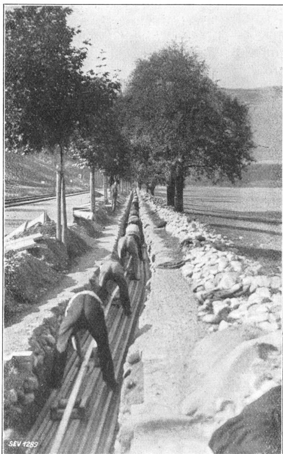
Fig. 4. Einziehen der Kabel.
