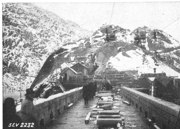
Fig. 6. Krone der Seeuferreggsperre mit Strasse zum Hospiz; Blick gegen den Grimselnollen.
