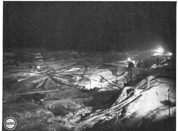
Fig. 1. Flutlichtbeleuchtung eines grossen Steinbruchgeländes.
