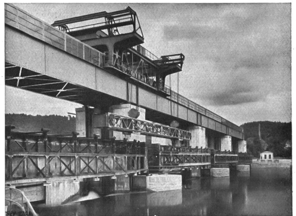
Fig. 6. Le barrage vu de l'amont, avec les panneaux de secours et le pont roulant pour leur manœuvre.
