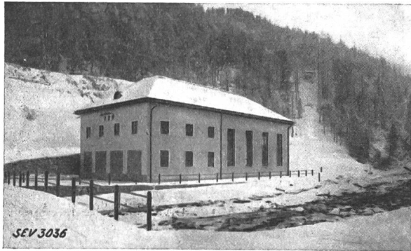
Fig. 1. Maschinenhaus des Kraftwerkes Isas.
