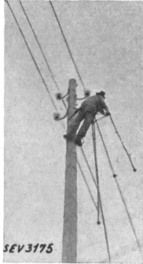
Fig. 9. Kurzschliessen und Erden einer 45-kV-Leitung mit der Wurf-Kurzschlussvorrichtung. Der Monteur ist zum Werfen des Seiles bereit. Fig. 10. Der Monteur schwingt das Seil. Fig. 11. Der Monteur hat das Seil geworfen. Es hat sich um die Leitungsdrähte geschlungen.
