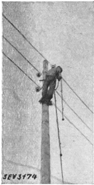
Fig. 9. Kurzschliessen und Erden einer 45-kV-Leitung mit der Wurf-Kurzschlussvorrichtung. Der Monteur ist zum Werfen des Seiles bereit. Fig. 10. Der Monteur schwingt das Seil. Fig. 11. Der Monteur hat das Seil geworfen. Es hat sich um die Leitungsdrähte geschlungen.
