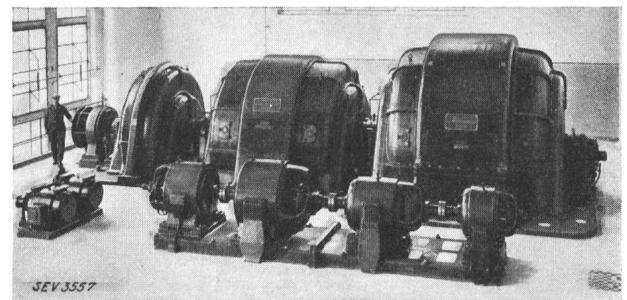
Fig. 24. Frequenzumformer Mühleberg.
