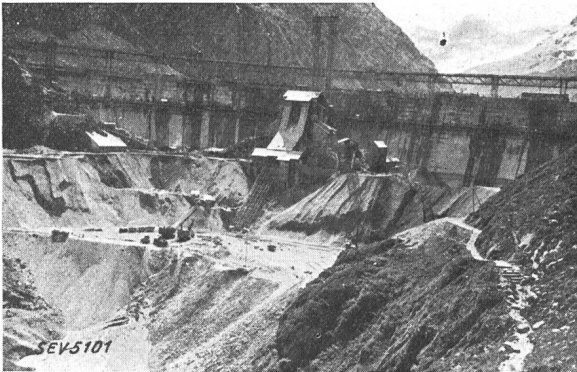
Fig. 12. (Phot. Briffod) Staumauer, Luftseite, mit Betonauflaufanlagen.
