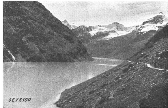
Fig. 13. (Phot. Briffod) Der Stausee.
