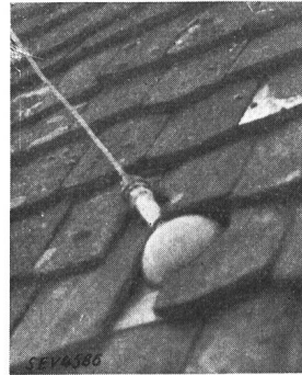
Fig. 3. Dachankereinbindung auf Ziegeldach.
