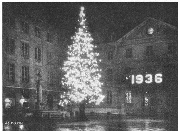
polies intérieurement, montées sur douilles normales et alimentées par du courant  $2 \times 125$  volts au moyen de conduites volantes. L'arbre est fixé directement dans le sol.
