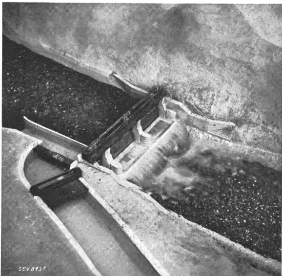
Fig. 5. Wasserfassung zum Mitteldruckwerk.
