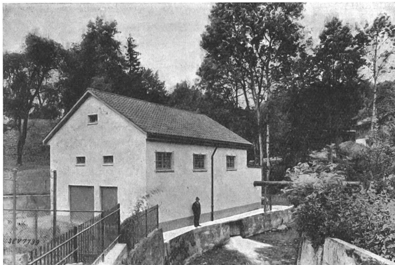
Fig. 3. Bâtiment des machines.
