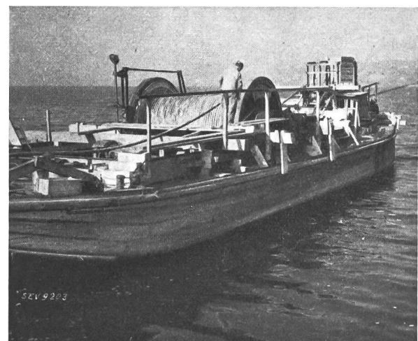
Fig. 6. Aufwickeln des Kabels auf dem Schiff.
