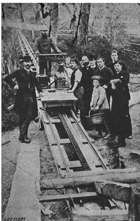
Fig. 1. Installation d'essais d'un chemin de fer électrique à crémaillère à Territet (1886)
