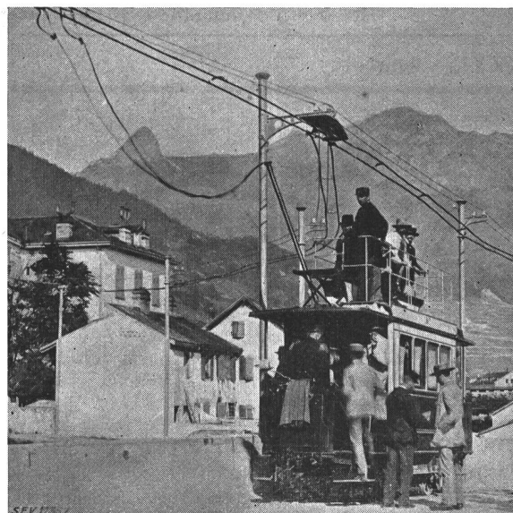
Fig. 2. Voiture motrice du premier tramway électrique suisse, de 1888, avec ligne de contact bipolaire en tube fendu (voir fig. 3). (Ligne Vevey-Montreux-Chillon.)
