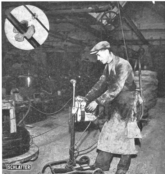
Fig. 3. Die Microweld-Schweissmaschine in der Zieherei Links oben der tellerförmige Grat
