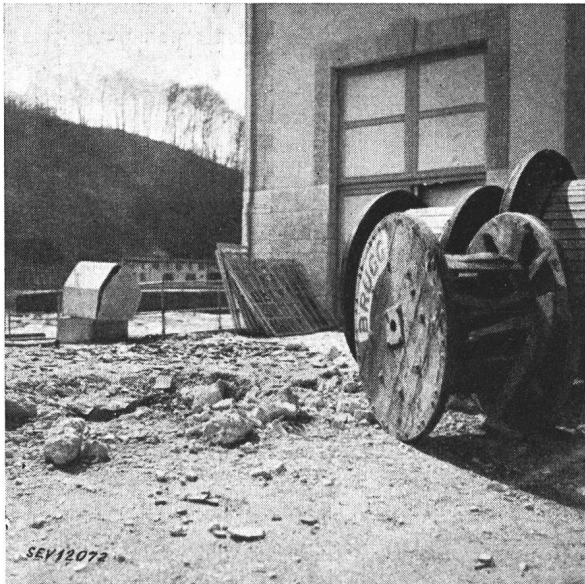
Fig. 13. Bobine de câble endommagée
