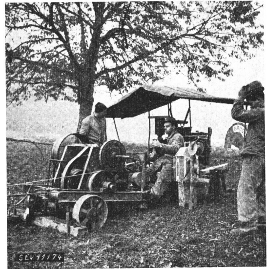
Fig. 37. Seilzugmaschine auf dem Baulos 12
