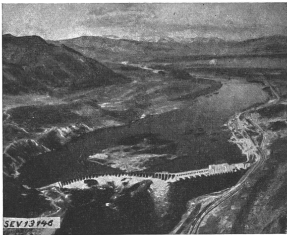
Fig. 9. Rock-Island-Kraftwerk [4 (später 10) × 16 667 kVA]
