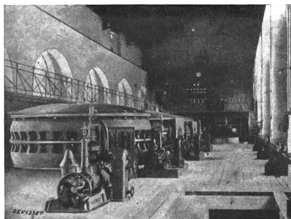
Fig. 7. Genève, usine de Chèvres. Salle des machines (1896)
