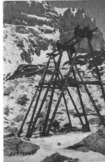
Fig. 9. Bockmast in Montage
