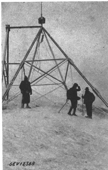
Fig. 8. Umgebautes Spezialtragwerk auf der oberen Schmelde
