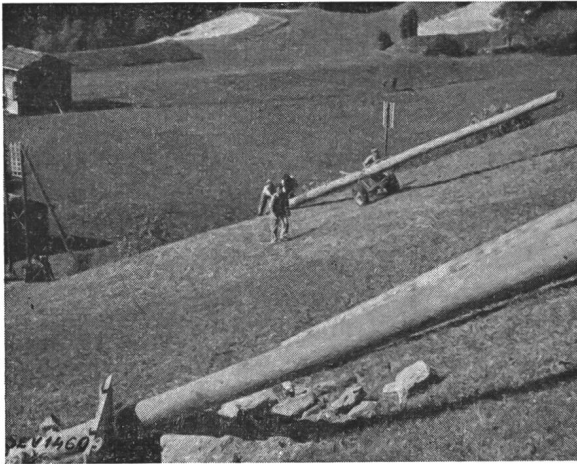
Fig. 12 Stangentransport mit Wagen und Winde
