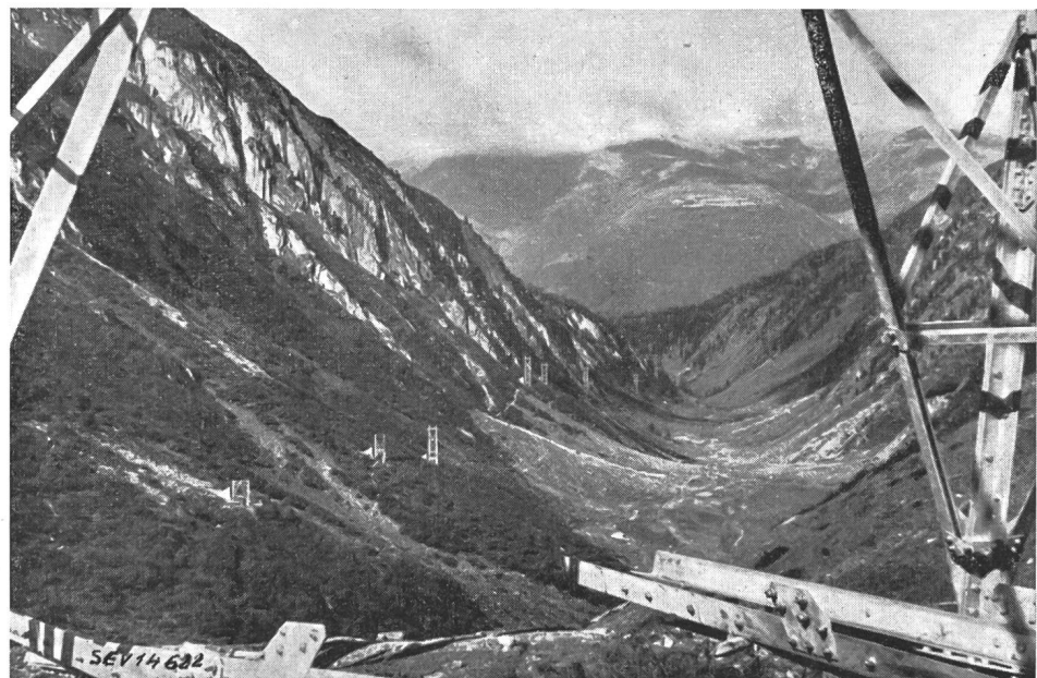
Fig. 24 Leitungstrasse im Aegingental von oberhalb Ladstätg (Mast 192)
