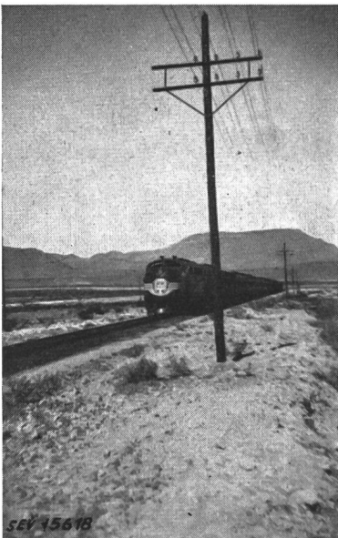
Fig. 4 Die Linien auf den neuen, mit Kreosot gestrichenen Holzmasten nach der Reparatur
