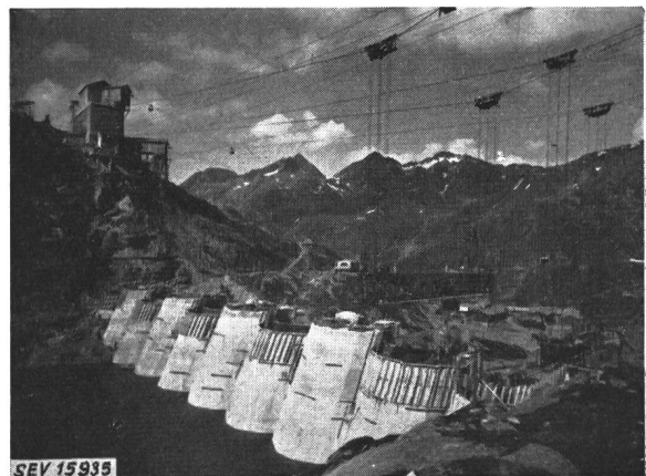
Fig. 2 Staumauer Lucendro im Bau von der Seeseite gesehen
