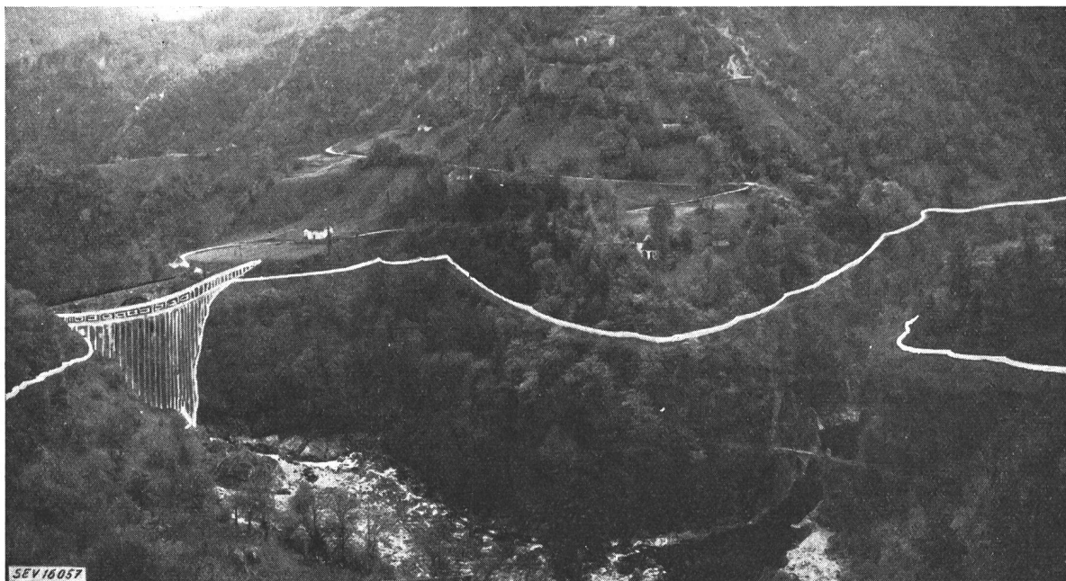
Fig. 6 Staumauer und Ausgleichbecken Palagnedra
