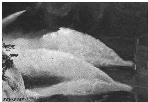
Fig. 4 Les vannes de fond donnent leur plein
