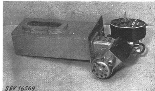
du niveau et s'écoule dans la cuvette du brûleur. Allumage à la main. Boîte à bornes fixée sur le moteur. Vis de mise à la terre.
