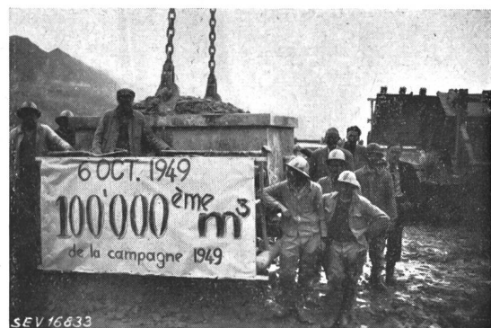
Fig. 7 Am 6. Oktober 1949 wurde der 100 000. Kubikmeter Beton des Jahres 1949 eingefüllt
