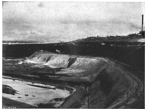
Fig. 1 Abbau der Braunkohlenschicht Das Wasserbecken im Vordergrund dient zur Speicherung des Löschwassers im Brandfall
