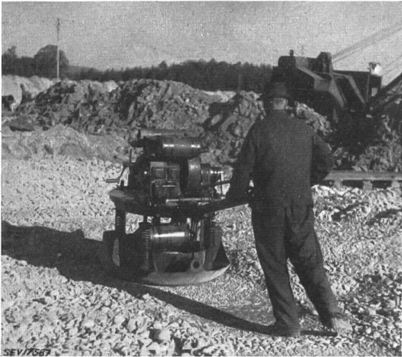
Fig. 7 Verdichten des Kieskoffers mit dem Vibrator
