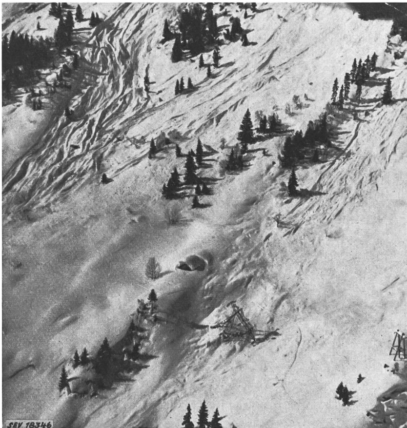
Fig. 5 Gotthardleitung westlich Airolo Der Mast Nr. 72 wurde durch die Lawine von Pian Secco zerstört (Rechts im Bild Holzmast einer 50-kV-Leitung)
