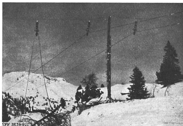
Fig. 8 Lukmanierleitung bei Acquacalda Provisorischer Stützpunkt mit Isolatorenketten an Tragseil
