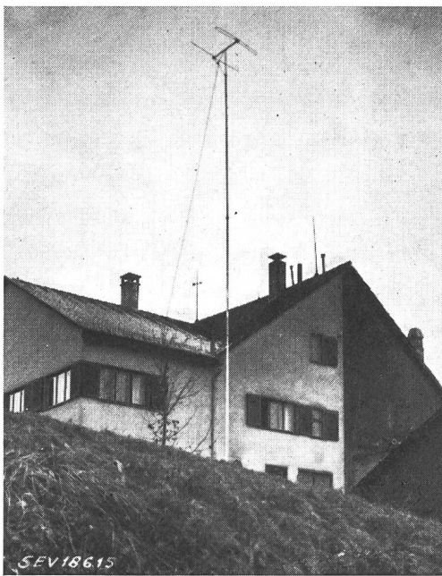
Fig. 2 Zweielemente-Antenne Empfangsversuche beim Tobelhof, Zürich
