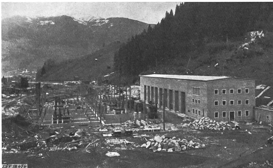
Fig. 6 Kraftwerk Uttendorf der ÖBB im Bau
