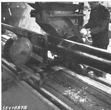
Fig. 2 Isolation d'une conduite d'eau (Zwahlen & Mayr, Lausanne)
