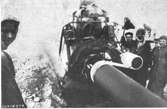
Fig. 1 Isolation d'un pipe-line dans le Moyen-Orient (Photo Fiberglass Ltd.)
