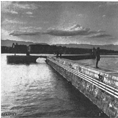
Fig. 5 Câbles électriques le long de la jetée
