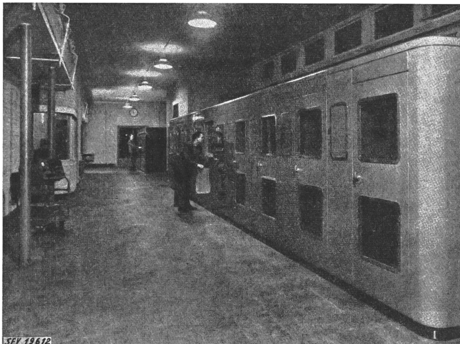
Fig. 3 Ansicht der Senderfront Im Vordergrund der Bildsender
