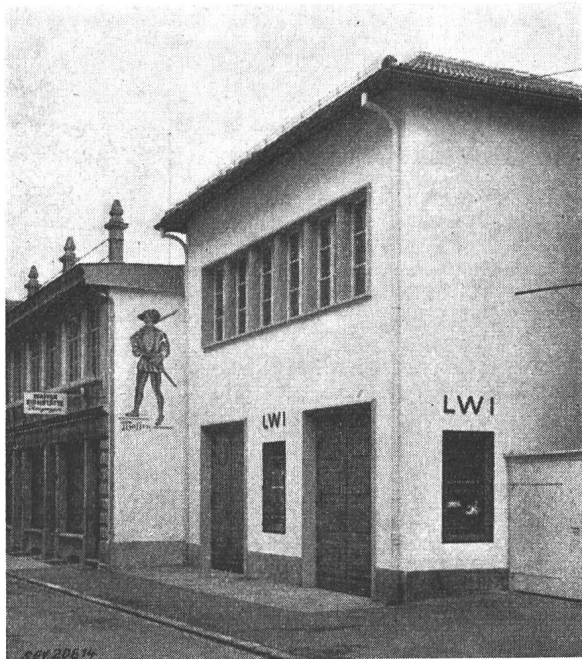
Fig. 8 Aussenansicht der Transformatorenstation
