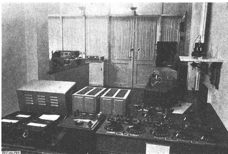
b) tableau de distribution central à 7 sections pour courants alternatif et continu. Ce tableau de construction inédite exécuté par la maison Electro-Tableaux Bienne
