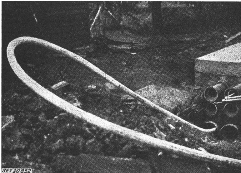
Fig. 3 Verlegung eines gerillten Aluminiumkabels an einer schwierigen Stelle
