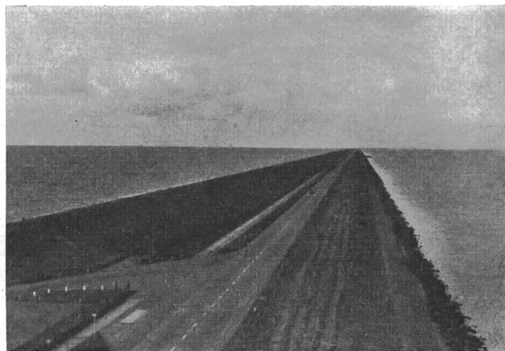
Fig. 11 La grande diga «Afsluitdijk» fra il Mare del Nord e il Mare Jjssel
