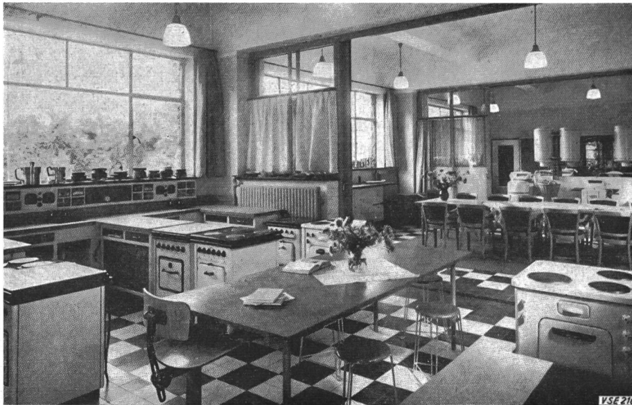
Fig. 8 Bâtiment pour l'enseignement: cuisine et buanderie électriques de démonstration
