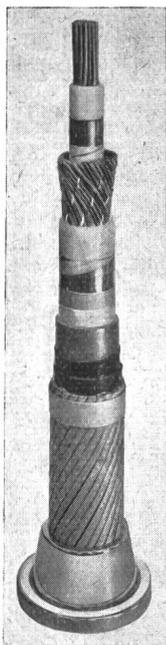
**Câbles à isolation papier avec manteau anticorrosif Cossoplast:** Le manteau anticorrosif en matière thermoplastique boudinée devient de plus en plus courant. Il constitue la meilleure protection du manteau de plomb et se place maintenant non seulement directement sur le plomb, mais aussi sur l'armure. Cossonay expose entre autres un câble 16 kV  $3 \times 150 \text{ mm}^2$  avec un manteau Cossoplast sur une armure de fils de fer méplats.
