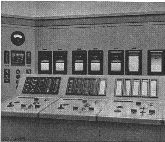
Fig. 3 Schaltpult und Schalttafel mit Profil- und Registrierinstrumenten
