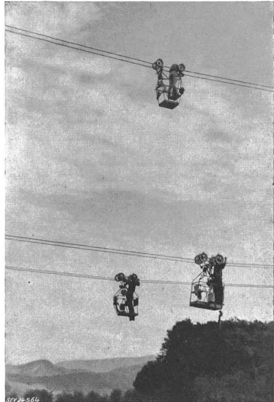
Fig. 22 Setzen der Feldabstandhalter im Zweierbündel mit waagrechter Anordnung
