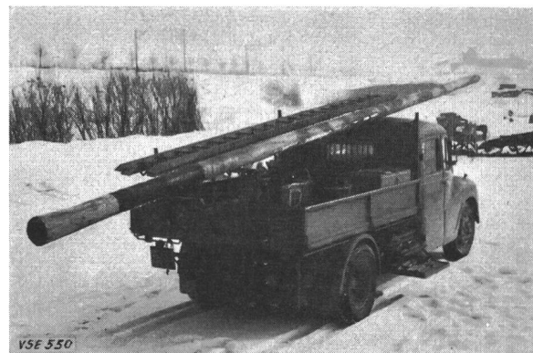
Fig. 6 Camion de la fig. 2: transport de poteaux sur chevalet
