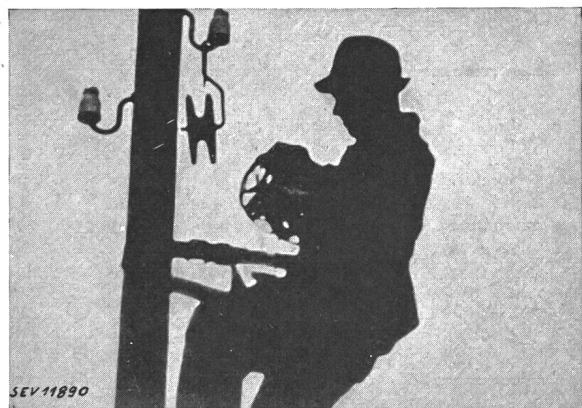
Fig. 4 Poulie de déroulage incorrecte Le diamètre de la poulie est trop petit
