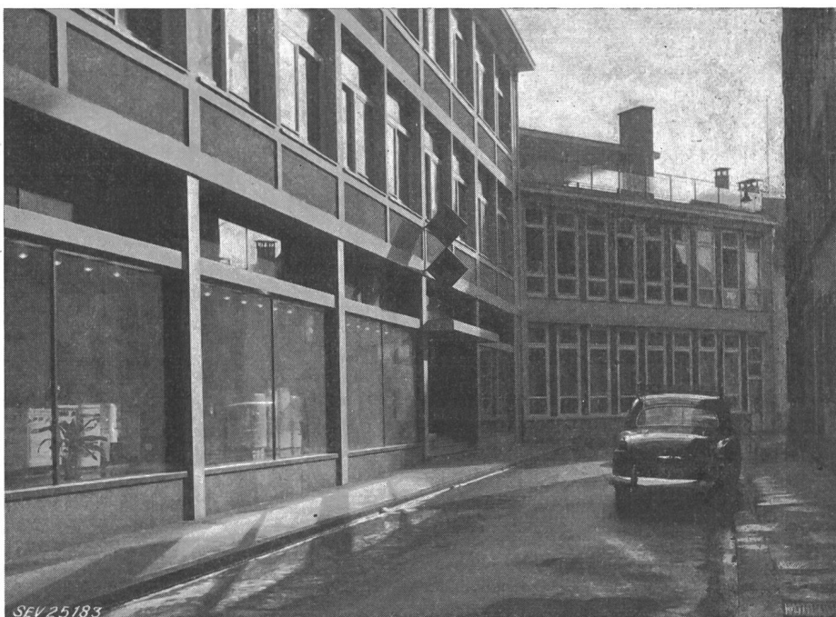
Fig. 11 Entrée de la salle à la Kohlenberggasse, avec les deux étages des écoles
