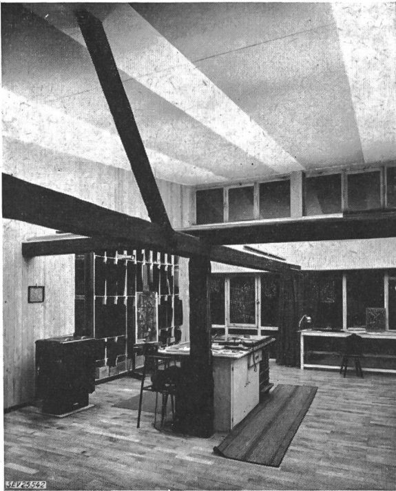
Fig. 9 Glasmaler-Atelier Rajsek in Boswil, Kt. Aargau Indirekt-Beleuchtung mit Fluoreszenzlampe, auf Balken montiert, 4 \times 40 \text{ W}
